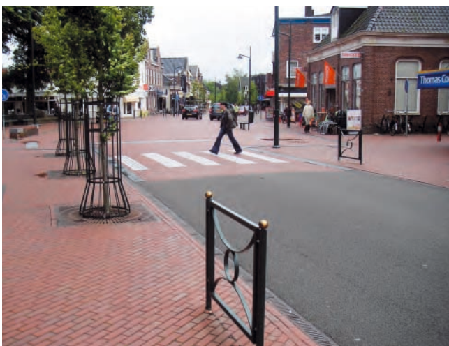
Fußgängerüberweg im Shared Space Bereich
