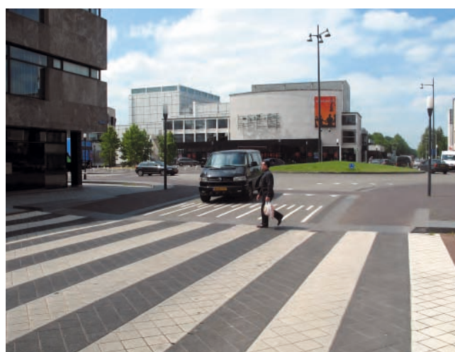
Fußgängerüberweg mit Noppenplatten
